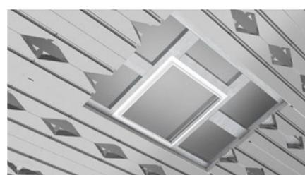
Die Module werden so ausgeschnitten, dass Deckeneinbauten ordentlich umfahren werden können.
