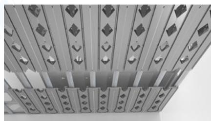
Zum Schluss werden die Module mit den Umlenkbögen, auf der gegenüberliegenden Seite des Raums, eingebracht.
