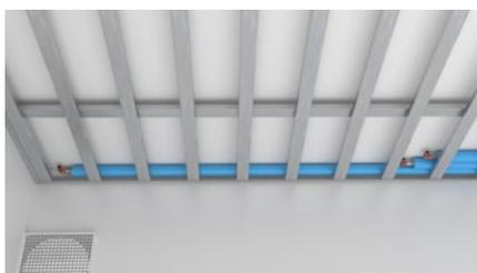
Der Planung wird die Lage der Anschlüsse für die jeweiligen Heizkreise entnommen und der Pressfitting auf das Rohr aufgesteckt.
