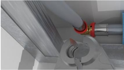
Das Systemrohr wird bis Anschlag in den Pressfitting gesteckt und verpresst. Für die Pressung wird eine Pressbacke in der jeweiligen Rohrdimension und einer **TH**-Kontur benötigt.
