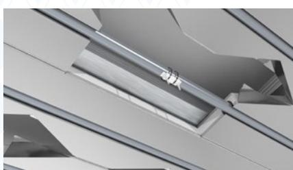
Je nach Anforderung ist es sogar möglich ein Teilstück auszuschneiden. Dies wird z.B. beim Setzen des Feuchtefühlers notwendig, oder wenn ein Pressverbinder benötigt wird.
