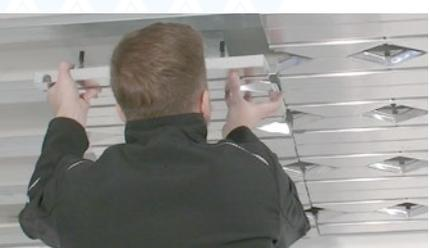
Die zugeschnittenen Module werden in die entsprechenden Freiräume eingesetzt.
