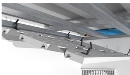
Die Module werden leicht geneigt an das erste CD-Profil angelegt und nach oben gedrückt.
