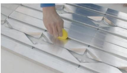
Vor dem Anbringen der Module müssen diese mittels Gleitmittel vorbereitet werden. Dabei wird der mitgelieferte Schwamm mit dem Gleitmittel besprüht und durch die Rohrrillen gezogen. **ACHTUNG:** In den Bögen darf das Gleitmittel **nicht** aufgetragen werden, da sonst das Rohr schlecht hält.
